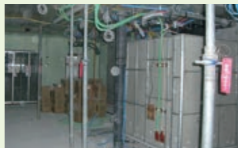
ユニット設置
