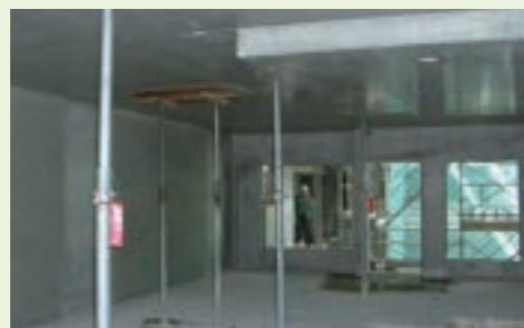
一般支保工解体後(打設後約4日目で降)
