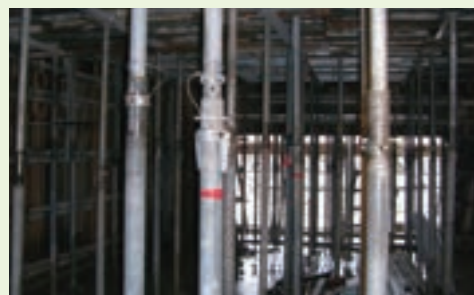
解体前(打設後約2日目)
