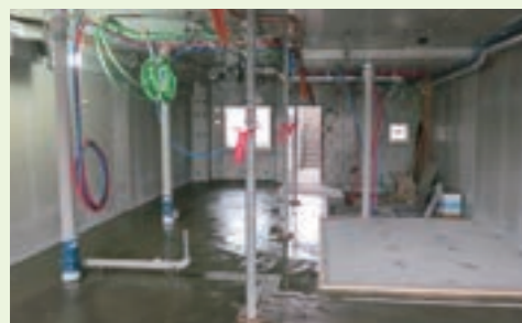
床レベリング工事
