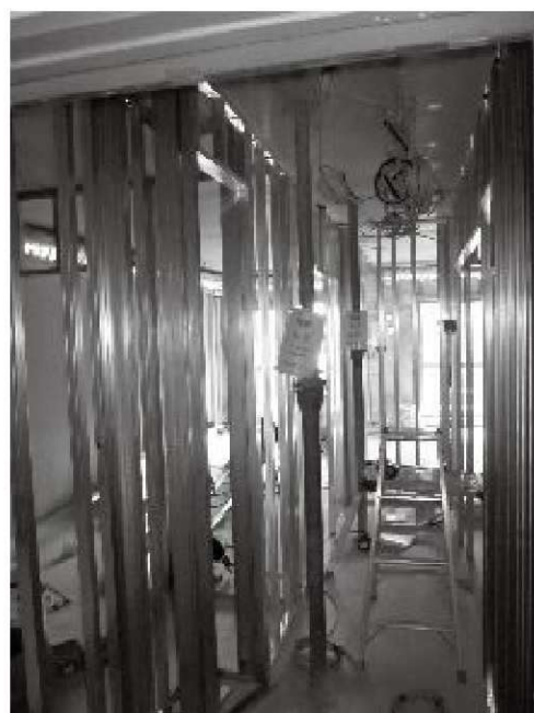
③ 残存支柱とLGS施工状況
