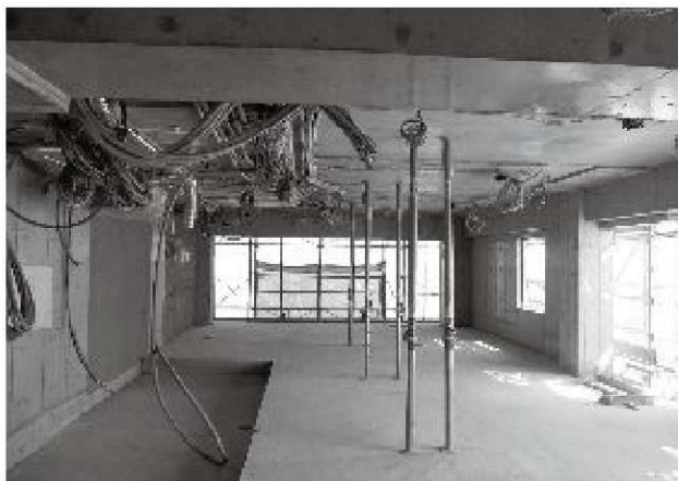
①残存支柱の状況
