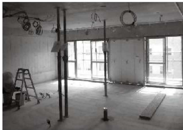
③残存支柱とサッシとALCの取付状況
