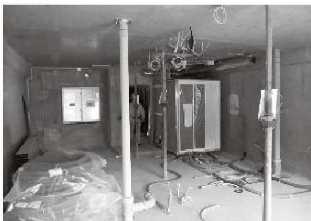
② 残存支柱とウレタン吹付、UB取付状況
