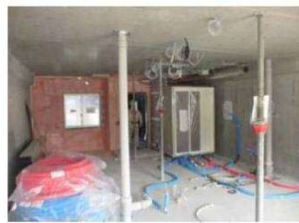
N-2階 室内状況
