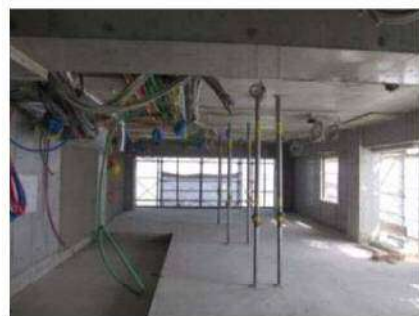
N-1階 室内状況
