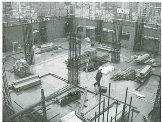
写真1 N階柱壁の型枠鉄筋組立状況
