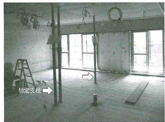
写真5 N-1階施工状況② [外壁ALC, サッシ取付け]
