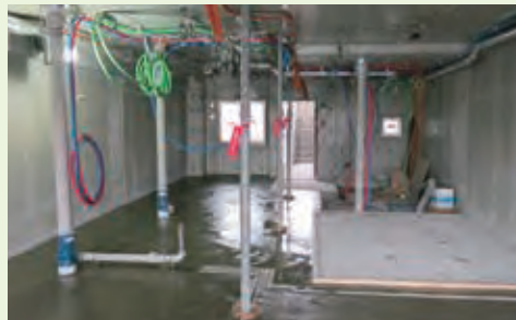
床レベリング工事
