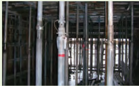
解体前（打設後約2日目）
