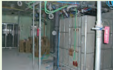
ユニット設置
