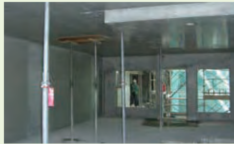
一般支保工解体後（打設後約4日目以降）
